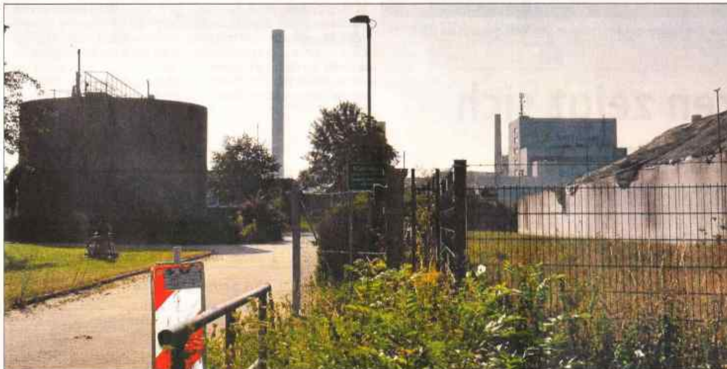
Die Kläranlage (links) und die Straßenbeleuchtung gehören zu den Großverbrauchern an Energie der Gemeinde Nordstemmen. Genau wie die Zuckerfabrik (im Hintergrund) bezieht die Kläranlage Strom von der angrenzenden Biogasanlage (rechts).
